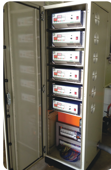
PAINEL ELÉTRICO COM GERADORES DE ULTRASSOM CTA DO BRASIL
